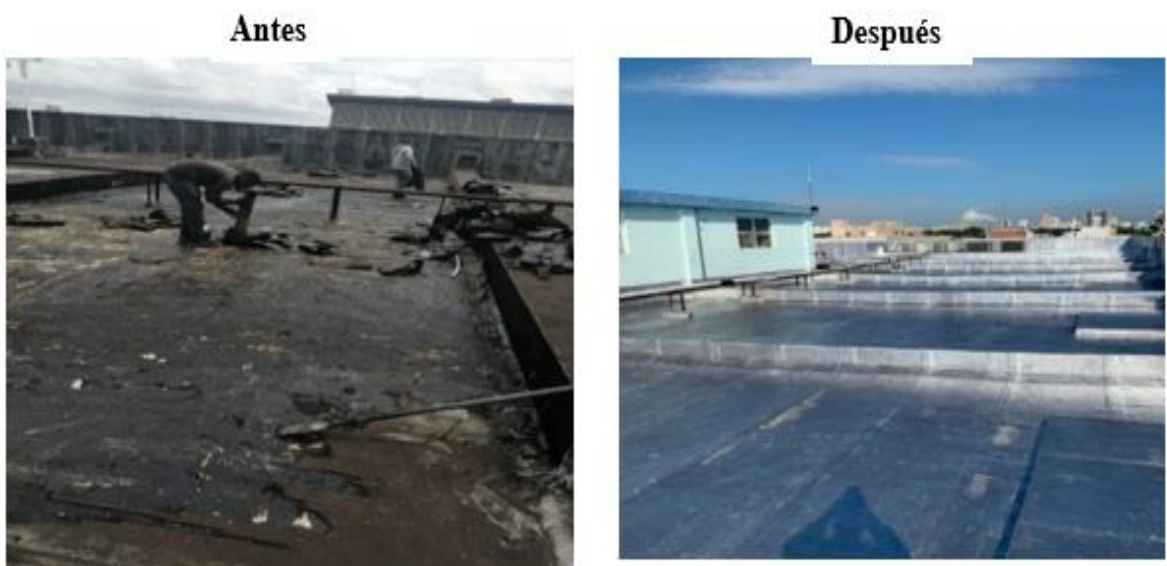
Impermeabilización de techo
