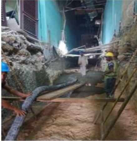
Vaciado de hormigón de reposición en ala Este del CEHICA
