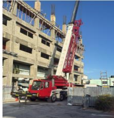
Transporte y colocación de las tijerillas del tercer entrepiso (4to nivel)
