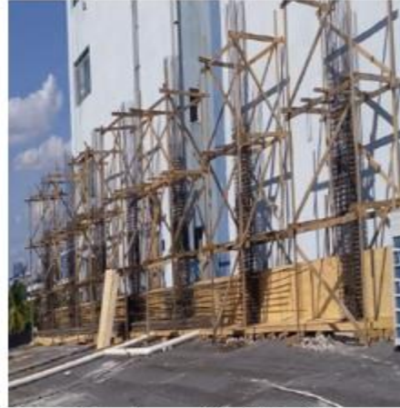
Armado de columnas del pórtico Este, sobre techo del CEHICA
