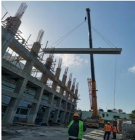
Transporte y colocación de las vigas doble T (DT) del segundo entrepiso (3er nivel)
